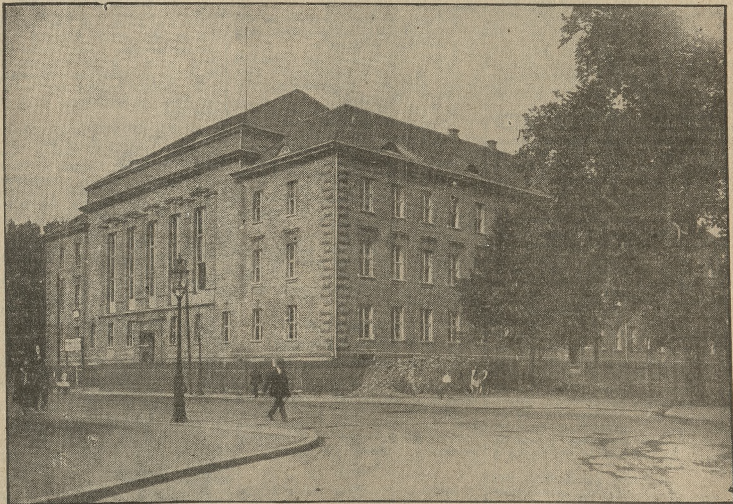
Nowopobudowany „Dom Rzemieślniczy”, w którego olbrzymiej, pięknej sali toczyć się będą obrady I. Wszechpolskiego Zjazdu Rzemiosła. Do głównych inicjatorów budowy „Domu Rzemieślniczego” należeli syndyk pozn. Izby Rzemieślniczej p. Kazimierz Juszcak, prez. Izby Rzemieślniczej w Poznaniu śp. Jewasiński, obecny prez. tejże Izby p. J. Staszak oraz radny miasta p. St. Libera.
