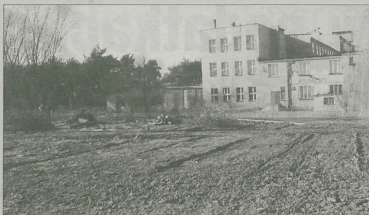
Nowa stacja benzynowa powstanie w Jarocinie na ul. Wrocławskiej (za „Jarkonem”). Właściciel Mirosław Miler planuje otworzyć ją już w lipcu. Na razie trwają prace związane z wyrównywaniem i uporządkowywaniem terenu
