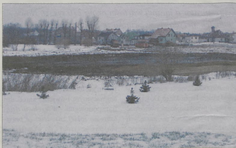
Od miesiąca teren przy stacji „Jet” przygotowywany jest pod budowę marketu
