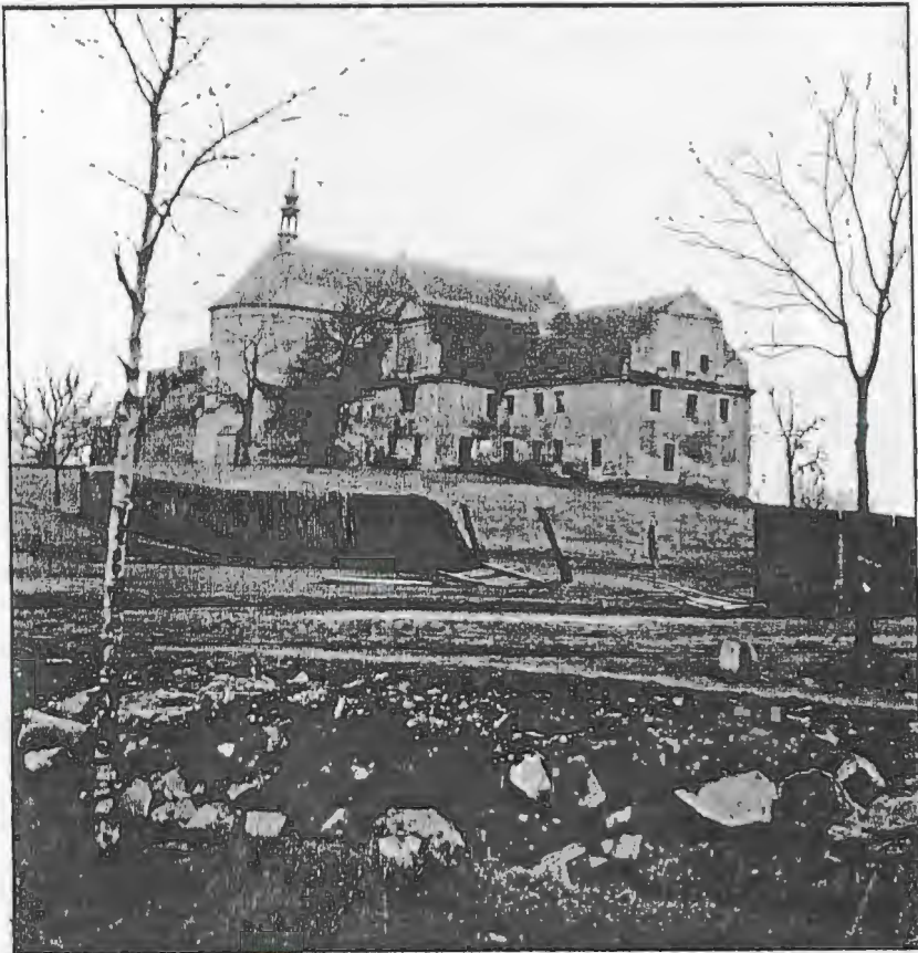
WIDOK NA KLASZTOR OD STRONY PÓŁNOCNEJ POWIJMOWANE: OKNA - ZNISZCZONE OTOCZENIE.
