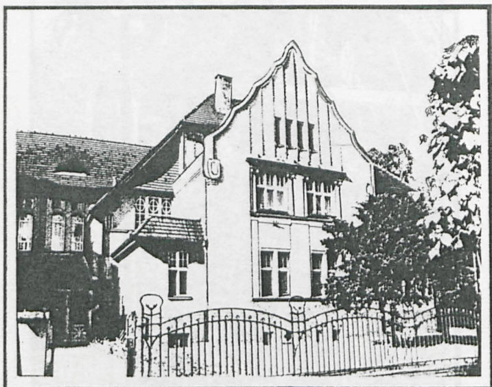
Budynek Starostwa Powiatowego w Ostrzeszowie przy ul. Zemkowej nr. 29
