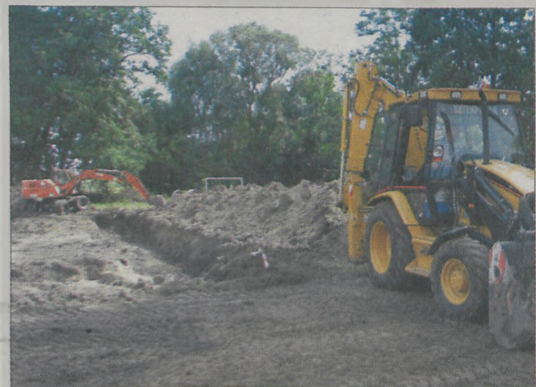
Rozpoczęły się prace przy budowie sali sportowej w Jaraczewie. „Hydrobudowa - 9” - przedsiębiorstwo, które wygrało przetarg na wykonawstwo robót, kopie przy zespole szkół fundamenty. W tym roku planuje się postawienie budynku w tak zwanym stanie surowym zamkniętym. Głównym inwestorem jest gmina Jaraczewo (900 tys. zł - koszty zaplanowane na ten rok) oraz Sejmik Województwa Wielkopolskiego (100 tys. zł)
