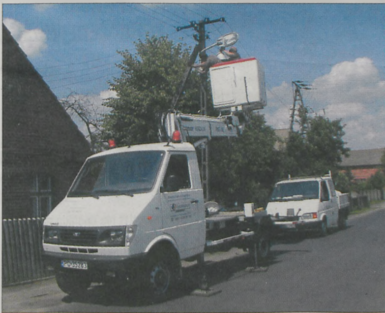
W ubiegłym tygodniu trwał montaż nowych lamp w Boguszynie
