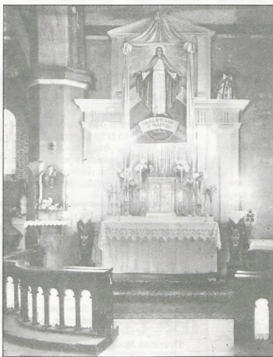
Ołtarz zastępczy na czas remontu w nawie bocznej
