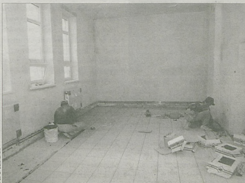
Remont siedziby jarocińskiego ZUS-u trwa już trzeci miesiąc
