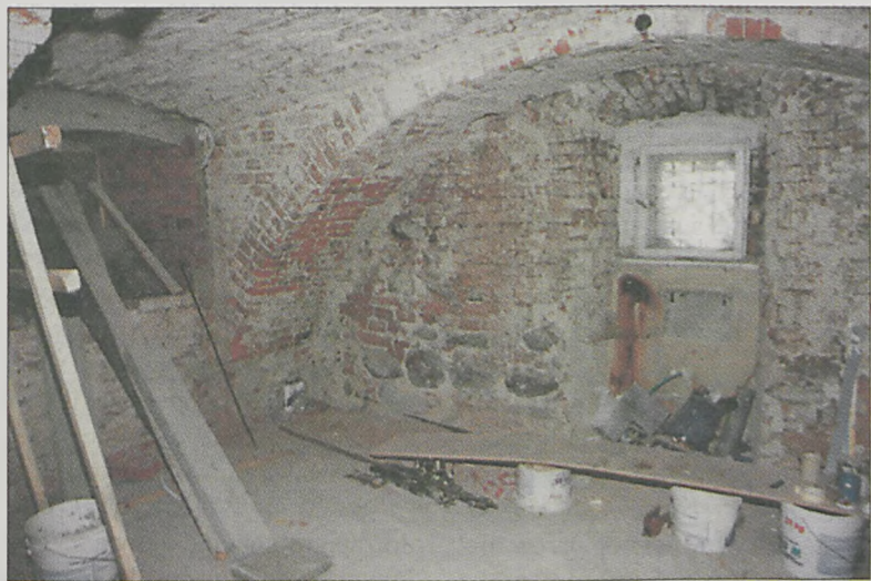
Pomieszczenia na pierwszym piętrze przygotowane są do nałożenia tynków. Być może niektóre mury pozostaną odsłonięte, aby pokazać zachowane łączenia cegieł z kamieniem
