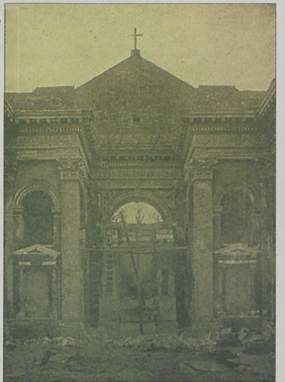
Wnętrze kościoła w Brzostkowie po spaleniu
