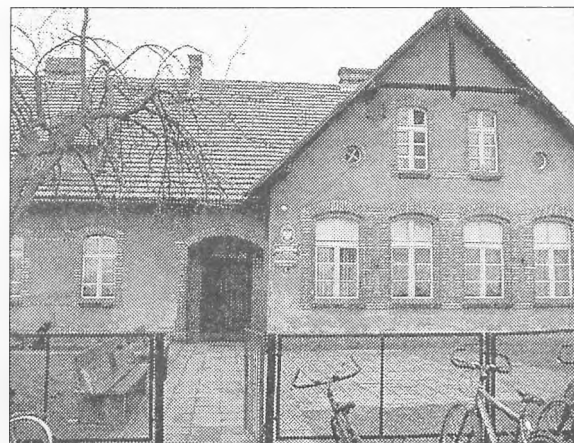
Fot. „Rzecz” - Romana Hyszczo Budynek skromny, ale wewnątrz bardzo zadbane
