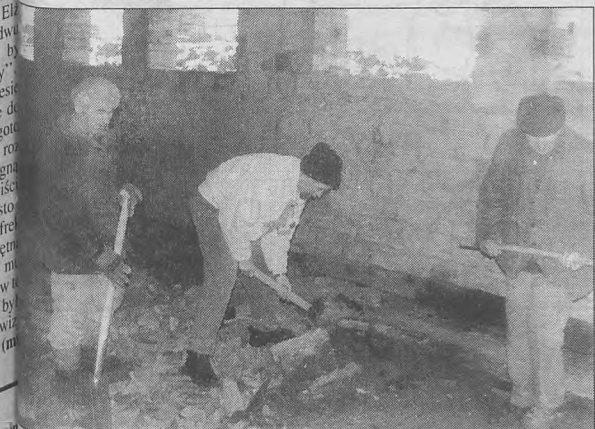
Strowiwas, ks. Stanisław Nasiński (w środku) i Marian Michalak nie szczędzą siły przy budowie nowego kościoła
