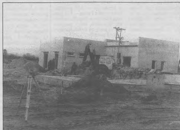
Na placu budowy oczyszczalni ścieków w Tuliskowie
