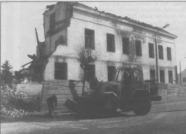
Rozbiórka postępuje w błyskawicznym tempie
