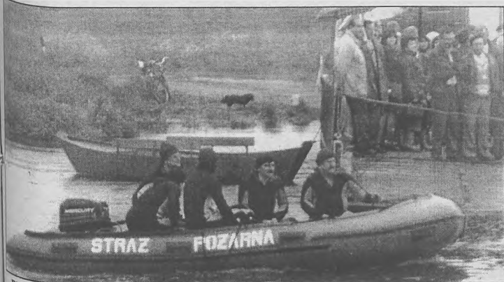
Pletwonurkowie asekurowujący przebieg stawiania zapory
