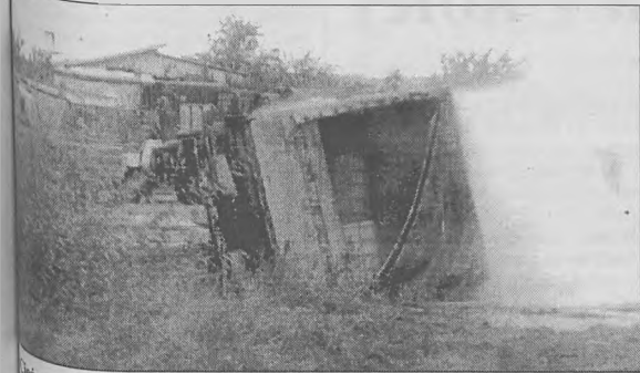
Na Obwodnicy z kwasem cały czas polewano wodą
