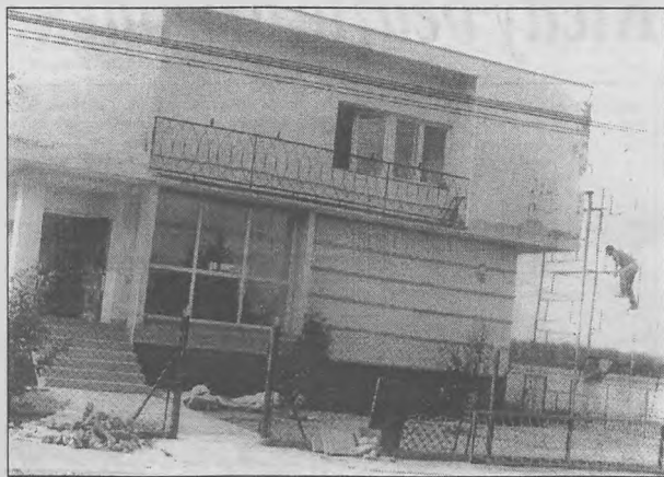
Prace remontowe są już na ukończeniu
