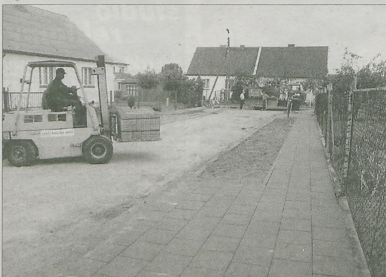
Trwają prace przy budowie ulicy Krzywińskiego w Chociczy. Powstaje chodnik, droga, krawężniki. Ulica będzie miała około 300 metrów długości. Gmina Nowe Miasto wyda na inwestycję około 200 tys. zł. Ukończenie prac zaplanowano w pierwszej połowie lipca
