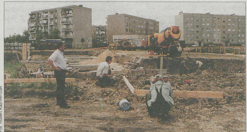
Prace budowlane już się rozpoczęły. Koszt ogólny inwestycji wyniesie 2.860 tys. zł
