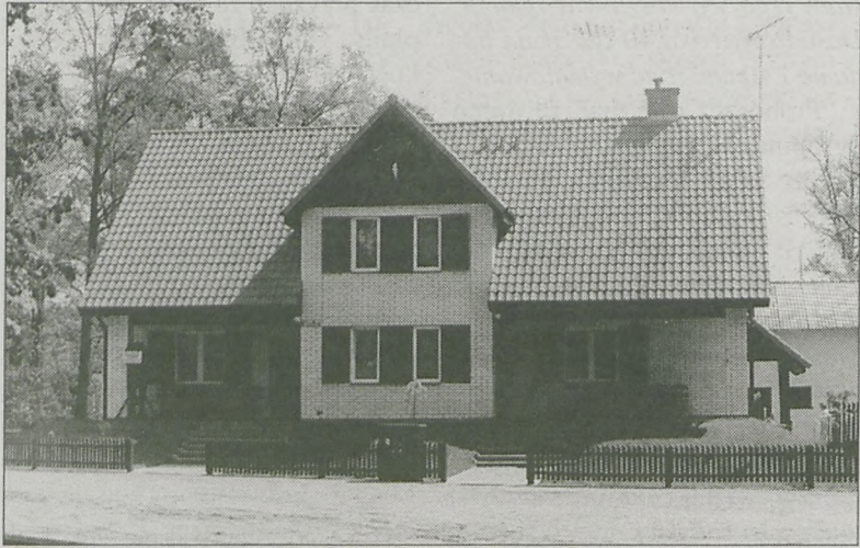
Do końca roku w Żerkowie wybudowana zostanie nowa leśniczówka. Pierwsza tego typu, na wzór wielkopolski, powstała w Boguszynie (na zdjęciu). Ta w Żerkowie będzie nieco mniejsza
