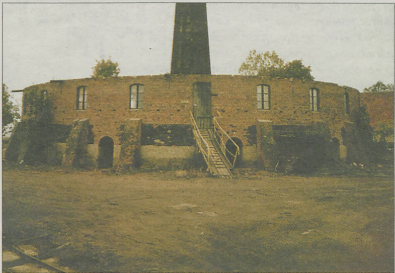
Zabytkowy piec kręgowy w Górze został w połowie rozebrany. Zdaniem konserwatora zabytków i inspektora nadzoru budowlanego jest to samowola budowlana
