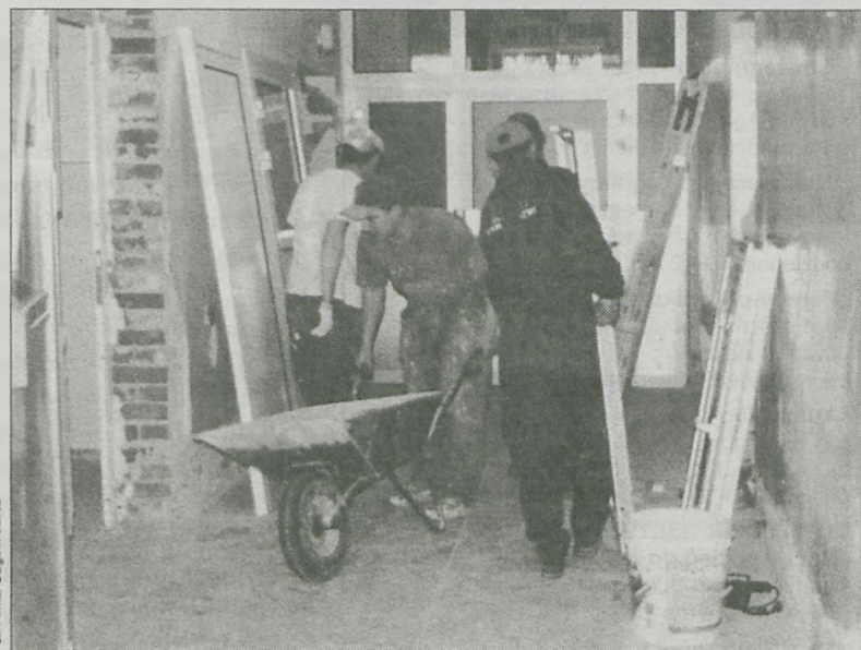
Najważniejsze prace remontowe zakończą się już w kwietniu
