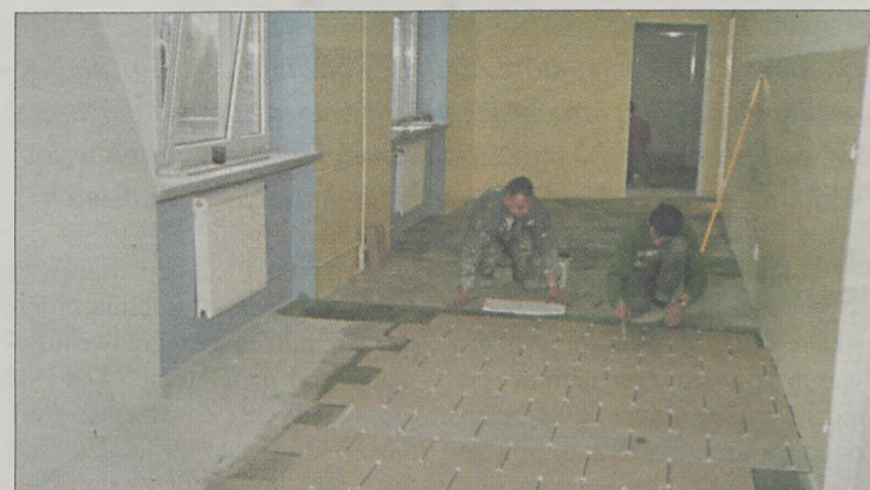
Prace wykończeniowe w budowanym gimnazjum w Chociczy potrwają do połowy marca
