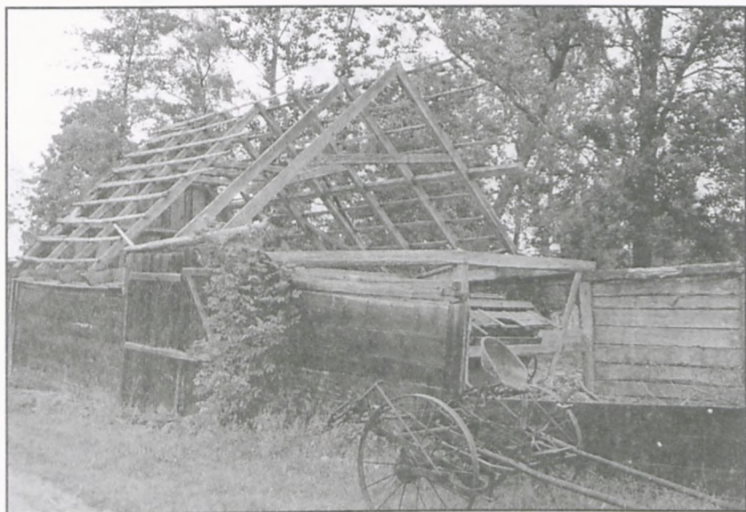
Rozbiórka ostatniej stodoły sumitkowo- lątkowej, maj 1997.
