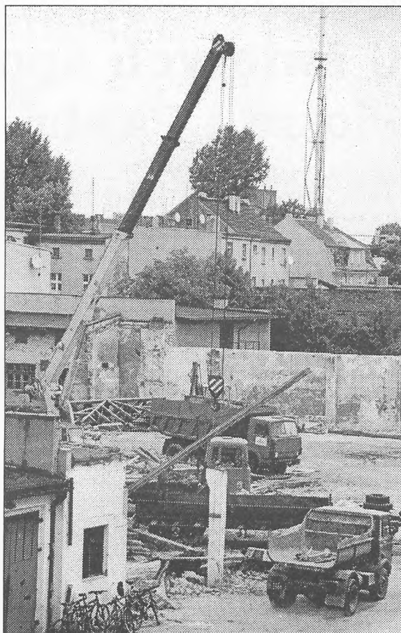
Fot. „Rzecz” - Marcin Pawlik Bardzo trudno będzie krotoszyńszanom przyzwyczaić się do nowego wyglądu placu przy ul. Słodowej, gdzie od ponad 120 lat stały budynki starej odlewni żeliwa. Na zdjęciu: prace rozbiórkowe zbliżają się do końca
