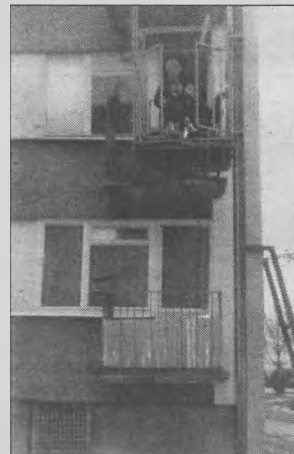
Tak wygląda zamontowany podnośnik
