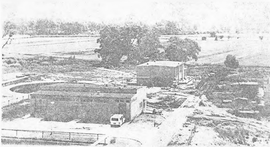
Widok ogólny — niewielki postęp robót w porównaniu z wiosną 1990 roku i pamiętnym artykułem „Oczyszczalnia — widmo. Zbliża się X-lecie”.
