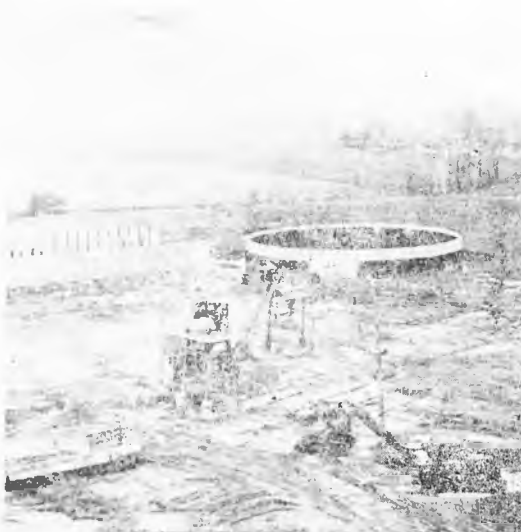
Fragment komór napowietrzających, osadnik wtórny
