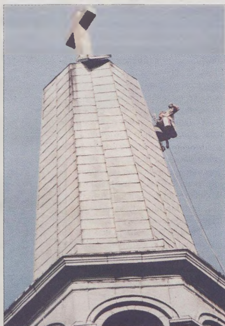
Prace na wieży kościelnej potrwają jeszcze kilka dni
