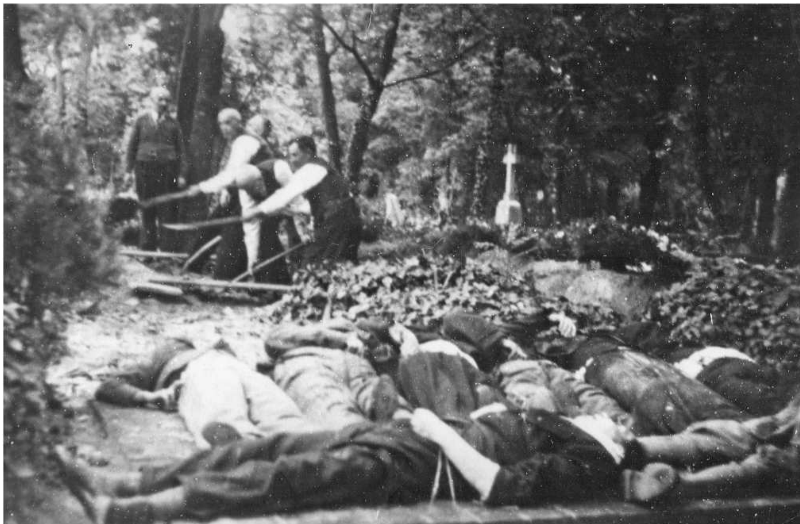
Kościan, 2 października 1939 roku, cmentarz zakładu psychiatrycznego, więźniowie kopią zbiorową mogiłę.
