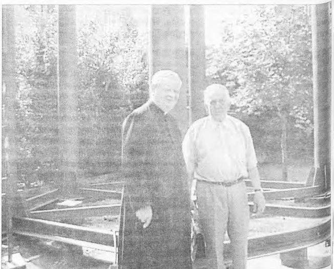
Ksiądz prałat Stanisław Adamski i inżynier architekt Stanisław Kozielski przy konstrukcji wieży
