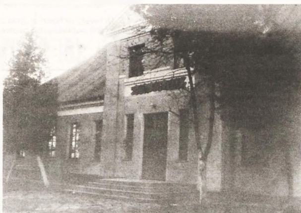
Budynek MGOK w Tuliszkowie
