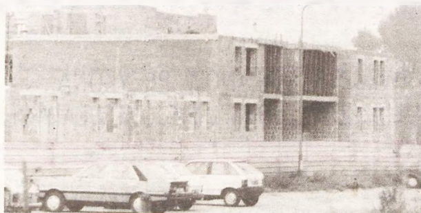
Blok w trakcie budowy (zdjęcie z 22 września)
