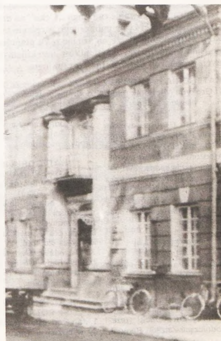
Budynek Urzędu Miejskiego w Dąbii
