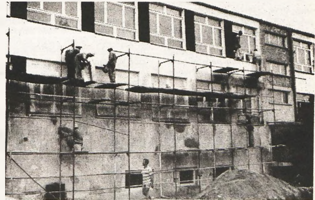
Prace przy nowej elewacji
