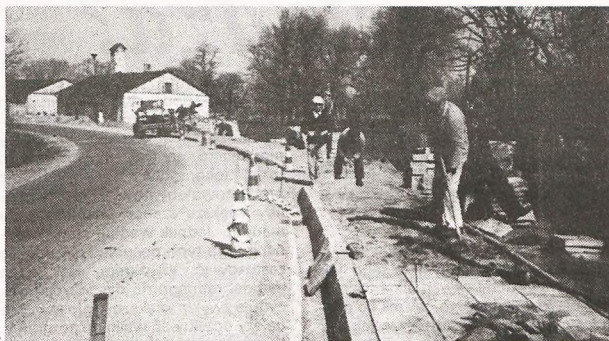
Prace przy budowie chodnika w Wietchininie
