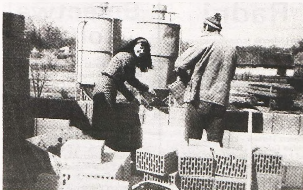
Pani dyrektor szkoły na budowie
