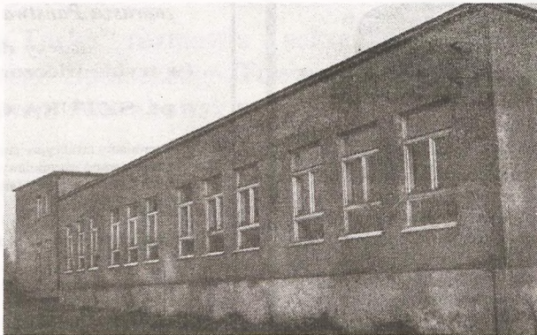
Niszczący budynek szkoły w Młodzianowie
