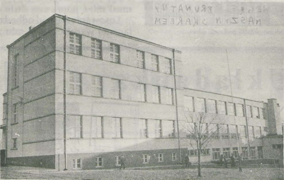
Budynek szkoły. Zdjęcie z 1974 roku
