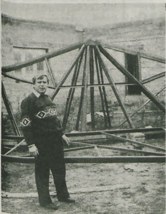
Pan Piotr Czekala przy budowie nowej remizy
