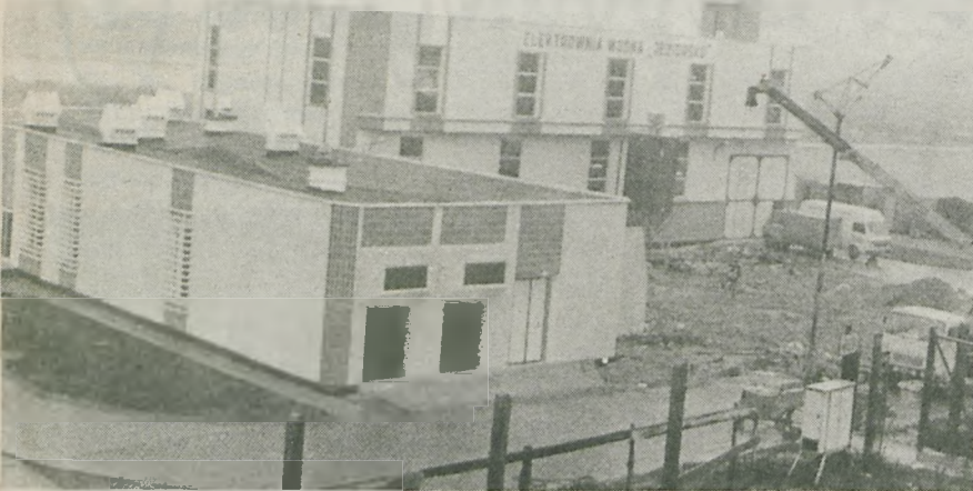
Elektrownia jest już na ukończeniu
