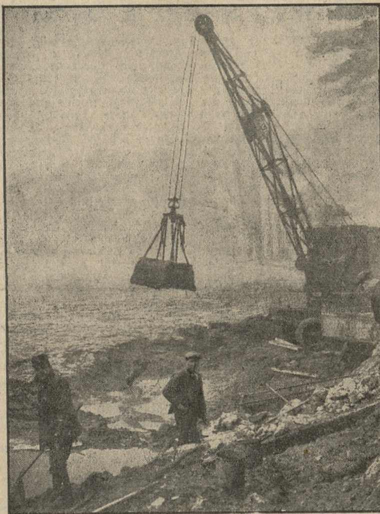
Mimo panującego kryzysu, gmina m. Paryża przystąpiła do przeprowadzenia szeregu robót, mających na celu podniesienia piękna „stolicy świata”. Na fotografii widzimy drągę, czynną przy pogłębianiu stawu w Bois de Boulogne.
