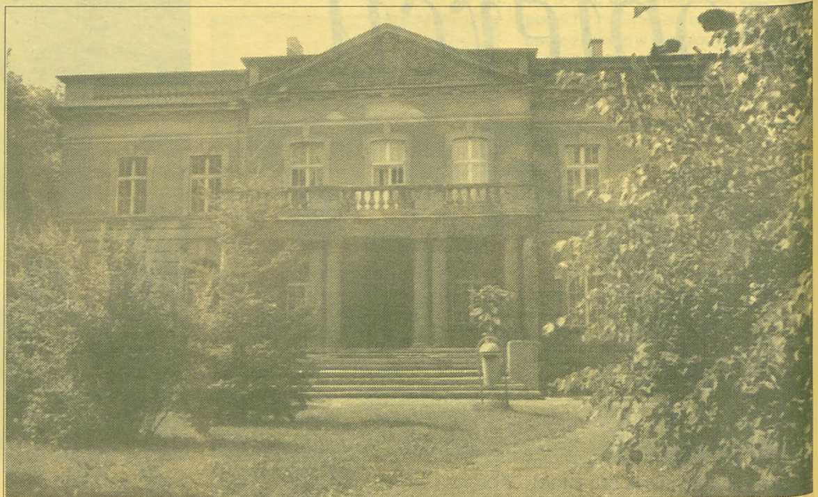
Elewacja frontowa (wschodnia) dobudowanego skrzydła dworu
