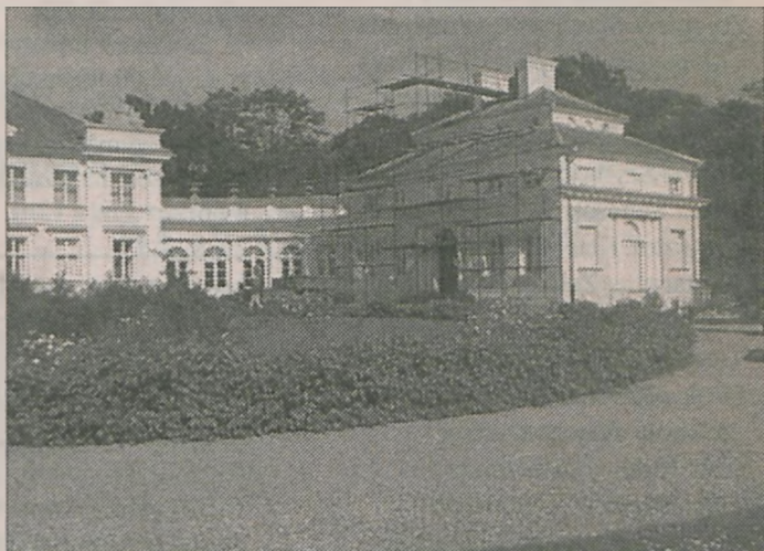
Elewacja pałacu w Śmiełowie została odrestaurowana. Ostatnie rusztowania były ustawione jeszcze we wtorek. W niedzielę, w czasie Pierwszego Zajazdu do Śmiełowa, nie będzie po nich śladu
