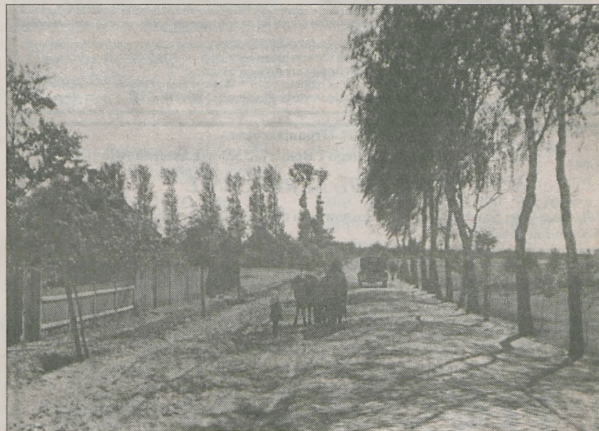
Droga pod Jarocinem z tzw. latówką (fot. z ok. 1928 r.)
