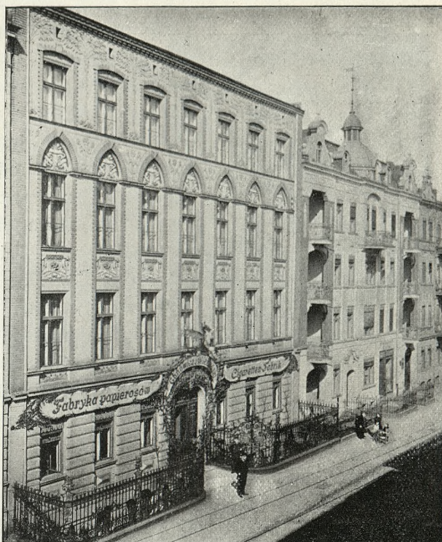
Ogólny widok fabryki przy ul. Moltkego 15.
