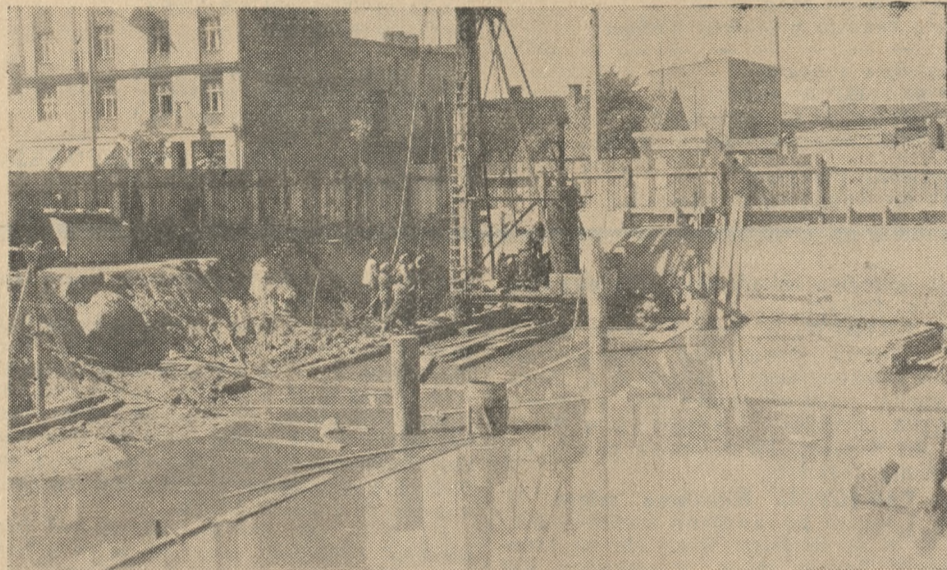
W Gdyni fundamenty spoczywają na palach
