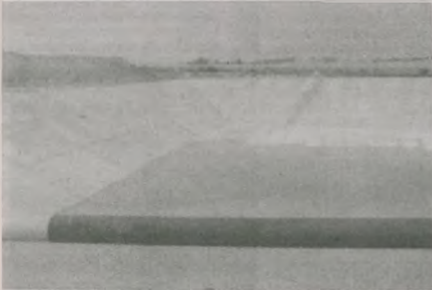
Zbiornik odcieków, z którego woda będzie używana do zraszania wysypiska śmieci Fot. Justyna Napieraj
