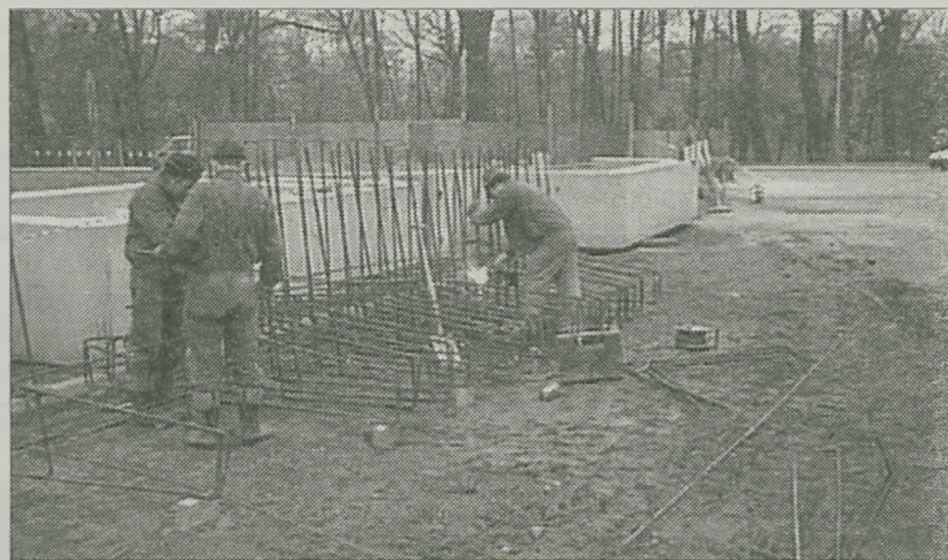
Przebudowa parkingu ma kosztować ponad 260 tys. zł. Koniec prac budowlanych przewidziano na czerwiec Fot. D. Fijolek
