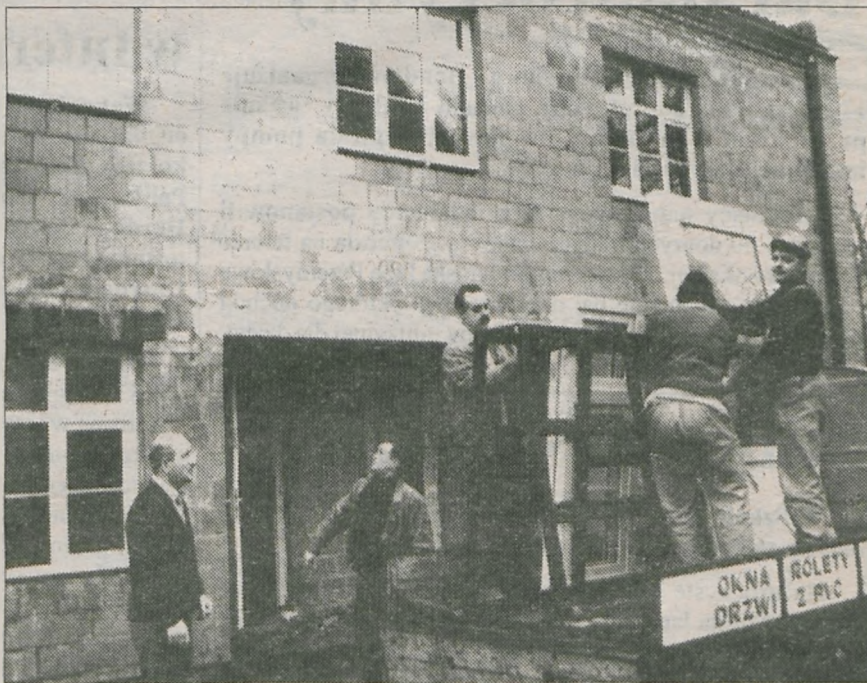
Trwa rozbudowa Szkoły Podstawowej w Jaraczewie. W przyszłości ma tam powstać także sala gimnastyczna FOTO Stachowiak
