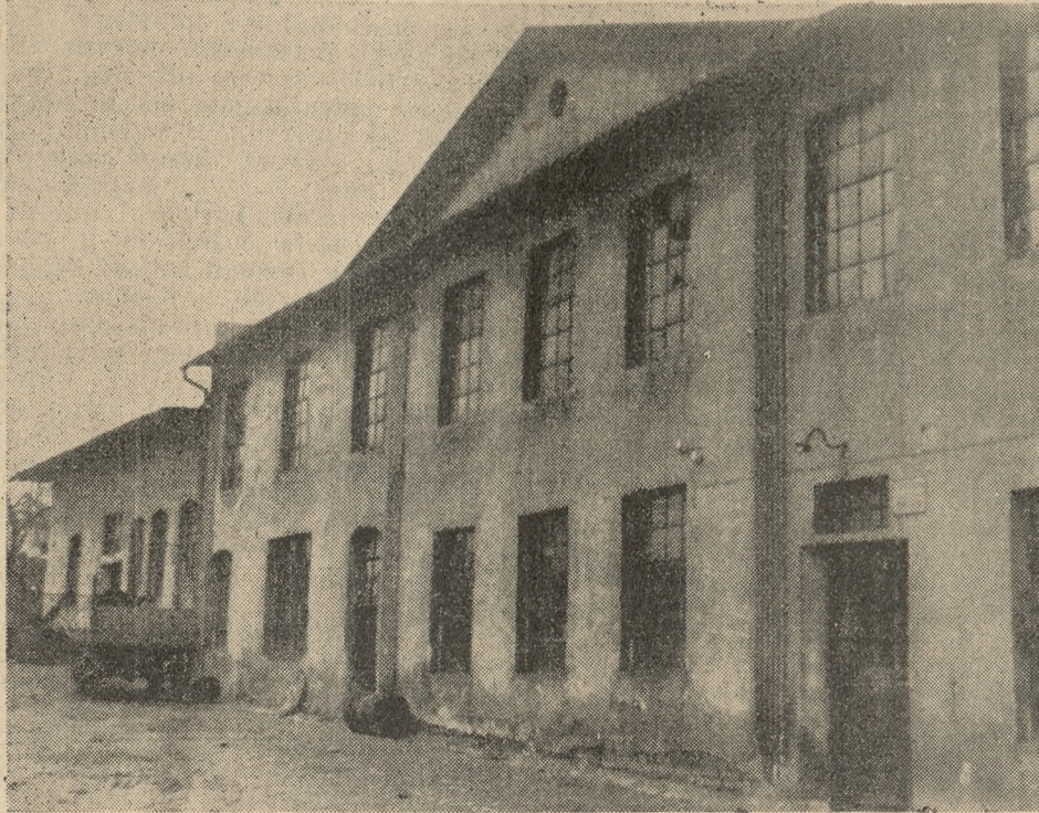
Żydowska fabryka mydła przy ul. Strumykowej 20
