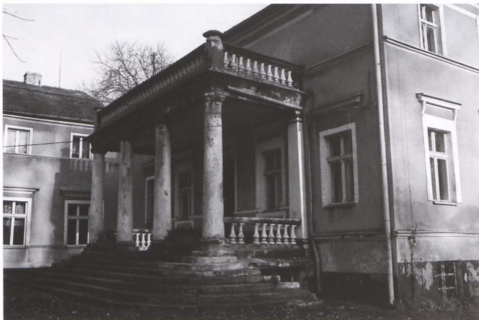
Opłakany stan pałacu
