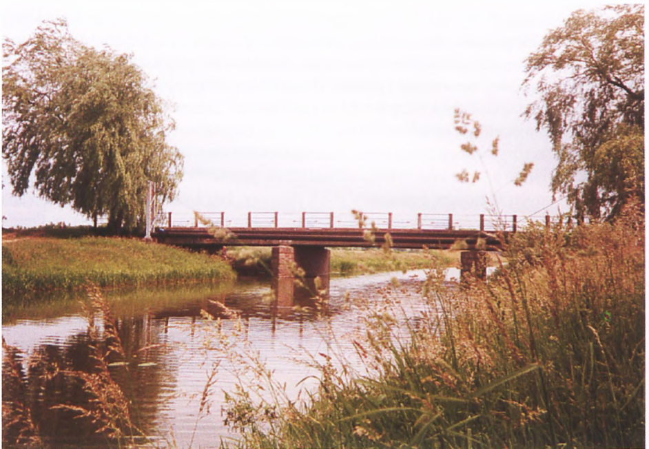
Obecny most betonowy
