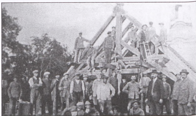
Ilustracja 18. Budowa czynem społecznym kościoła w Chobienicach. Wśród pracowników inicjator budowy ks. Władysław Żelazek.
